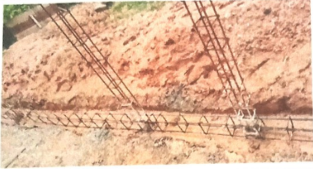
Foto 1: Colocación de bases para mejoramiento de la cocina
