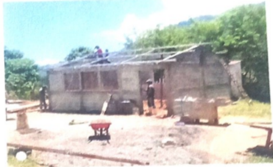
Foto 4: Mejoramiento de la cocina e instalación de costaneras de metal
