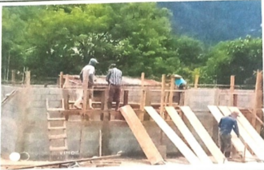
Foto 3: Mejoramiento de la cocina
