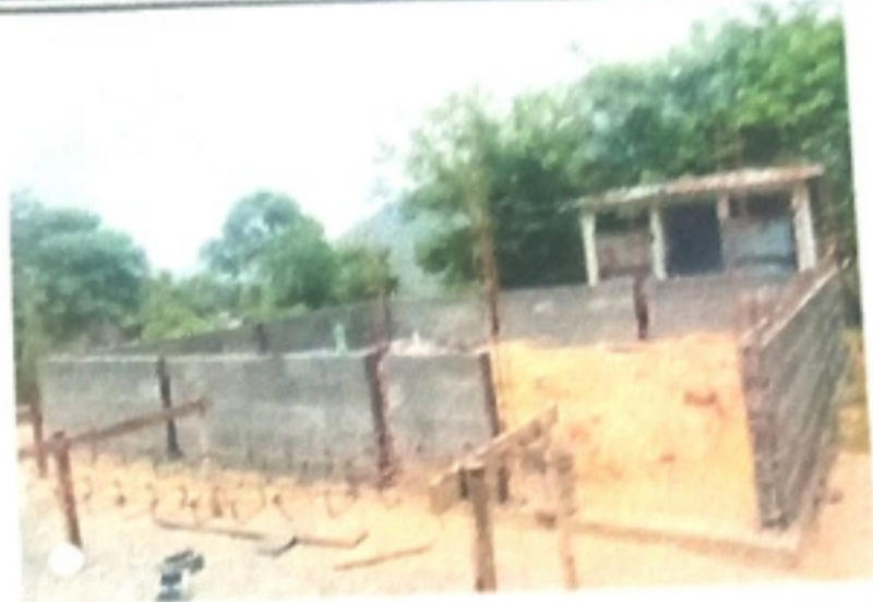
Foto 2: Mejoramiento de la cocina
