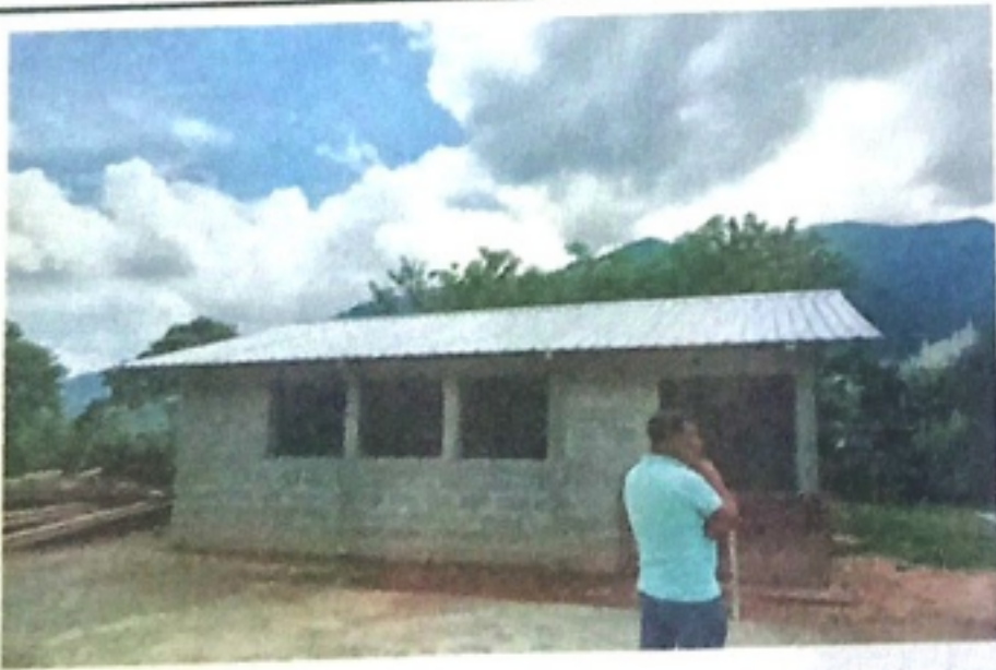
Foto 5: Mejoramiento de la cubierta de la cocina e infraestructura de la cocina
